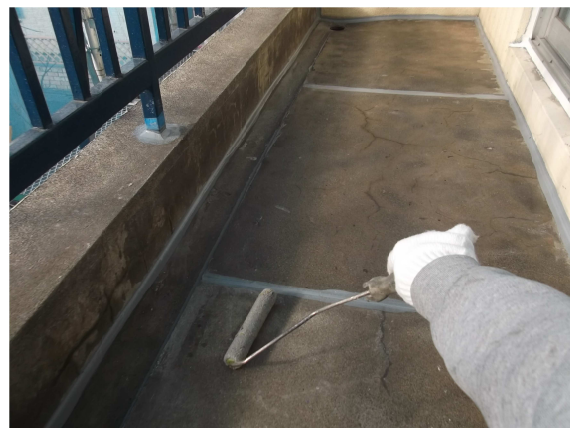
プライマー塗布
