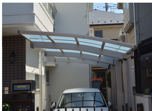
カーポート設置 同時施工
