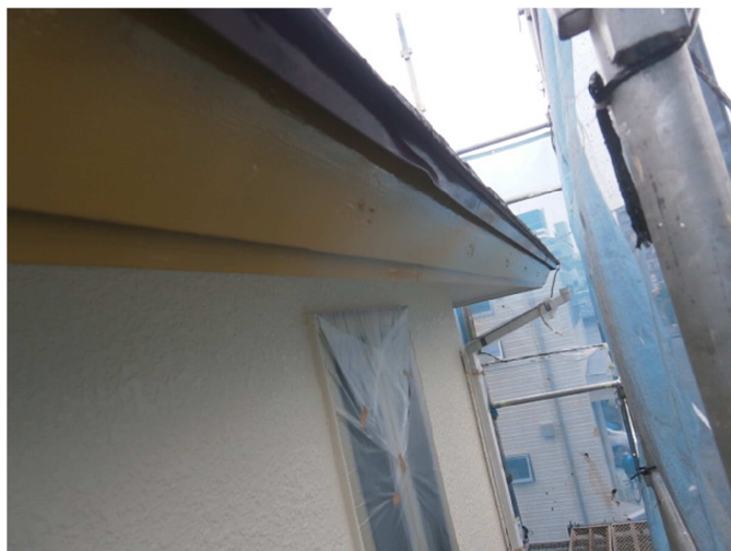
既存雨樋撤去後
