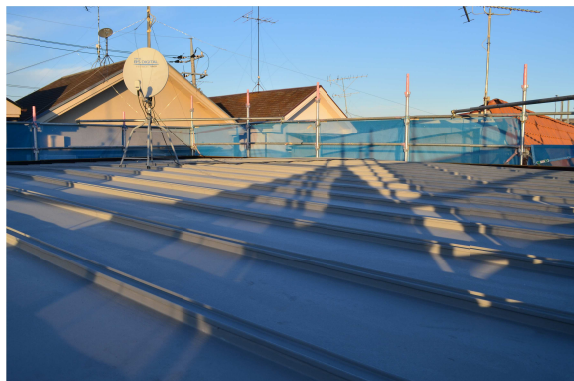
屋根塗装(ヒートカットパウダー配合)
